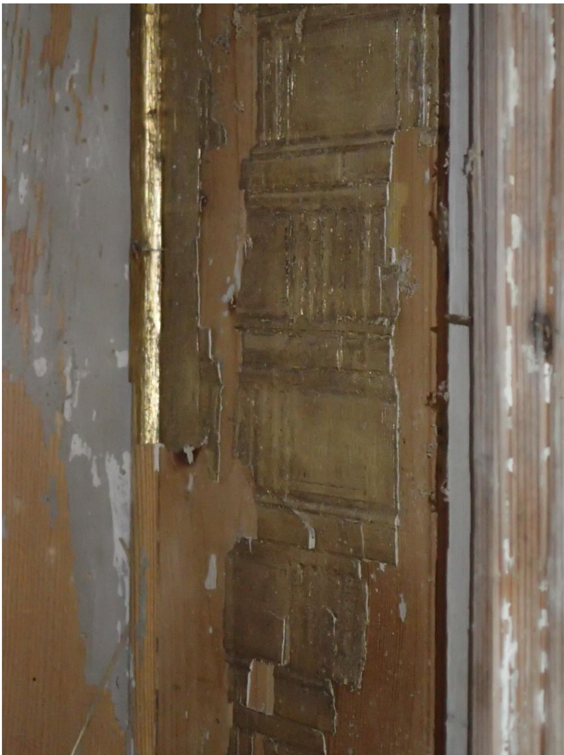
OBR . 11 Stav při průzkumu – detail svatostánku – vnitřní plochy Vnitřní plochy svatostánku jsou ve dvou dochovaných typech. Boční plochy jsou zlacené s plastickým dekorem napodobujícím čalounění /tapetu/. Toto dvojí řešení je zvláštní, protože boční plochy, vzhledem ke tvaru svatostánku, jsou špatně viditelné.
