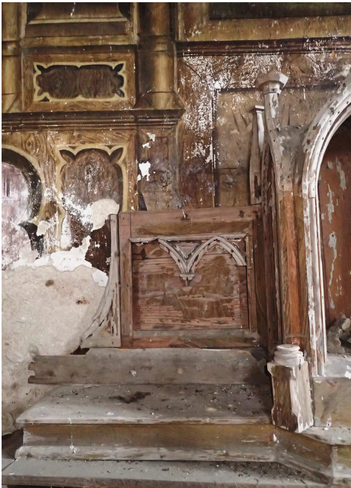
OBR . 22 Stav při průzkumu – detail – levá strana predely Dobře patrné je poškození výzdoby i fládrování.
