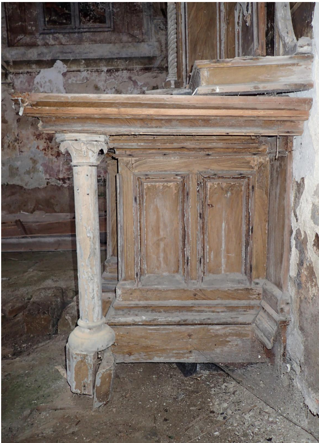
OBR . 23 Stav při průzkumu – detail – pravá strana menzy Dobře patrné je poškození výzdoby i stav fládrování.
