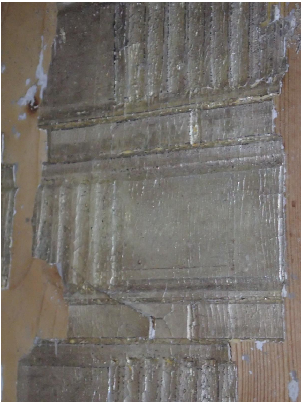
OBR . 12 Stav při průzkumu – detail svatostánku – vnitřní plochy - boky Boční plochy jsou zlacené s pravidelně se střídajícím plastickým dekorem napodobujícím čalounění /tapetu/.
