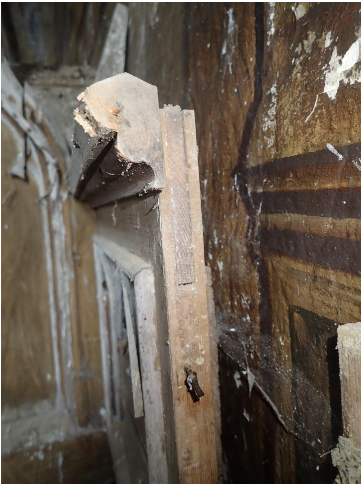
OBR . 20 Stav při průzkumu – detail – bok predely U predely chybí zakončení na boku. Dobře patrné je seříznutí horní profilové lišty na 45 stupňů a jsou vidět zbytky hřebíků upevňujících chybějící část.
