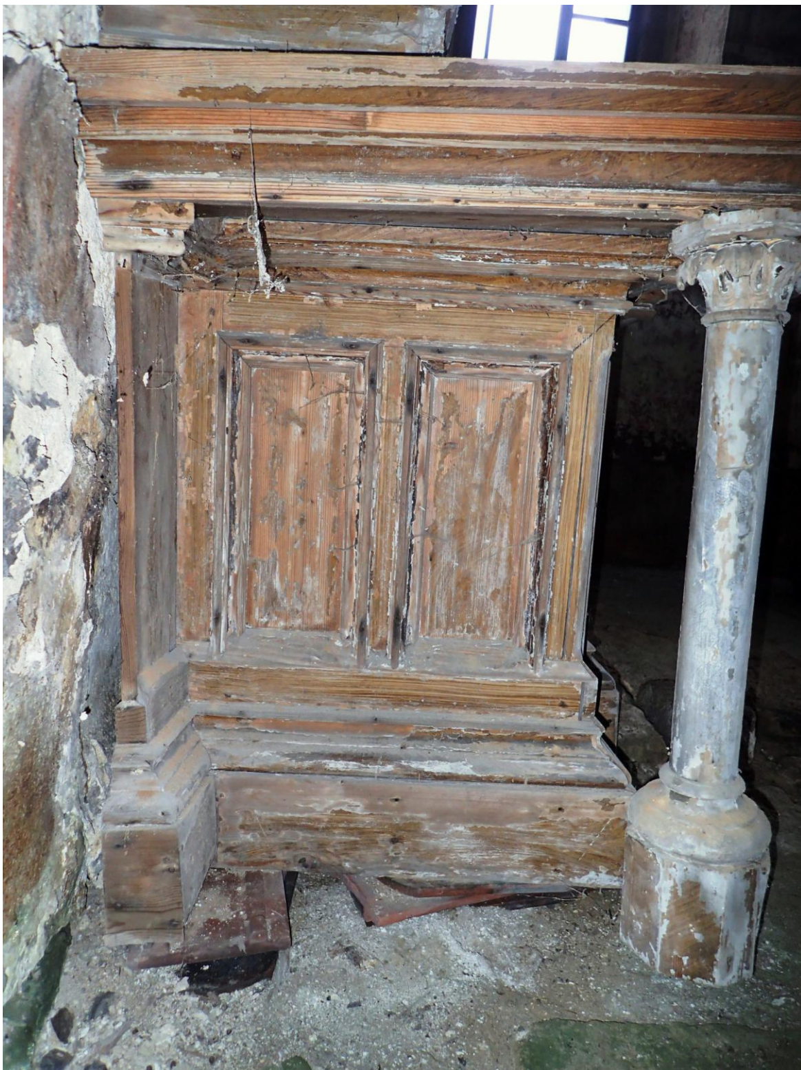
OBR . 24 Stav při průzkumu – detail – levá strana menzy Dobře patrné je poškození výzdoby i stav fládrování.
