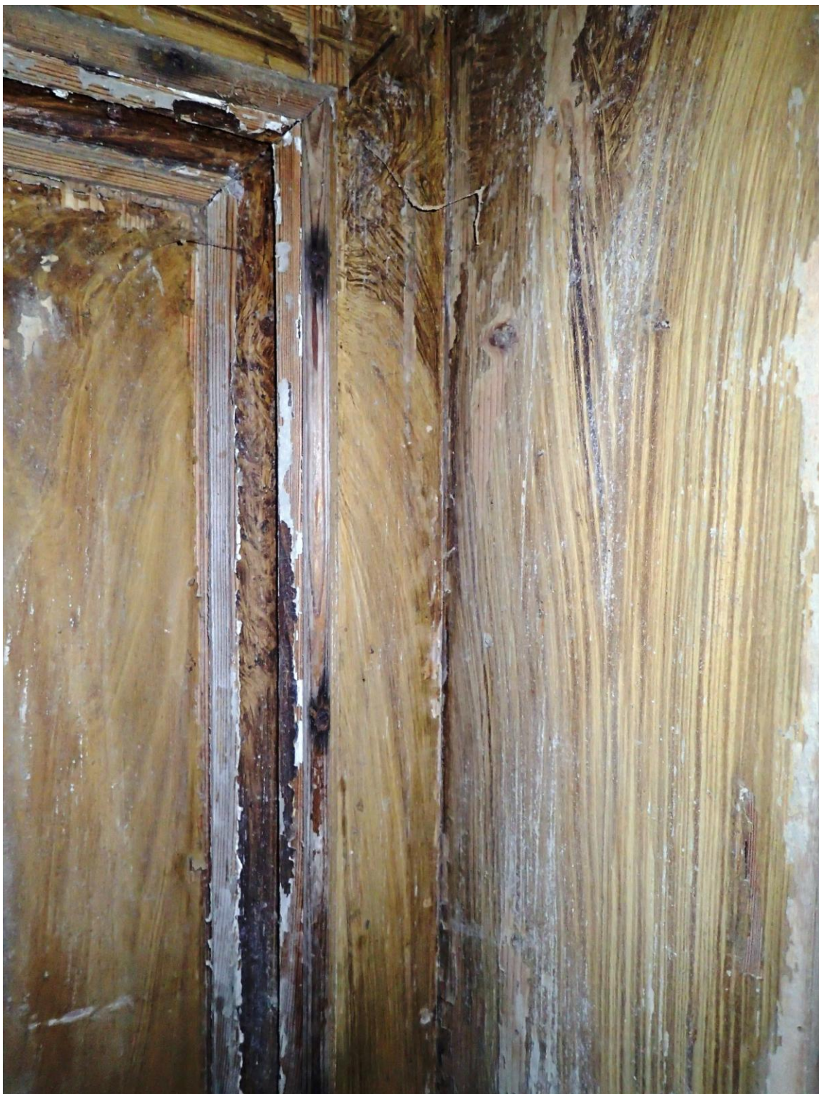
OBR . 30 Stav při průzkumu – detaily menzy – povrchová úprava Použitá technika fládrování je ve dvou odstínech – světlejší hnědá /plochy/ a tmavě hnědá /lišty/
