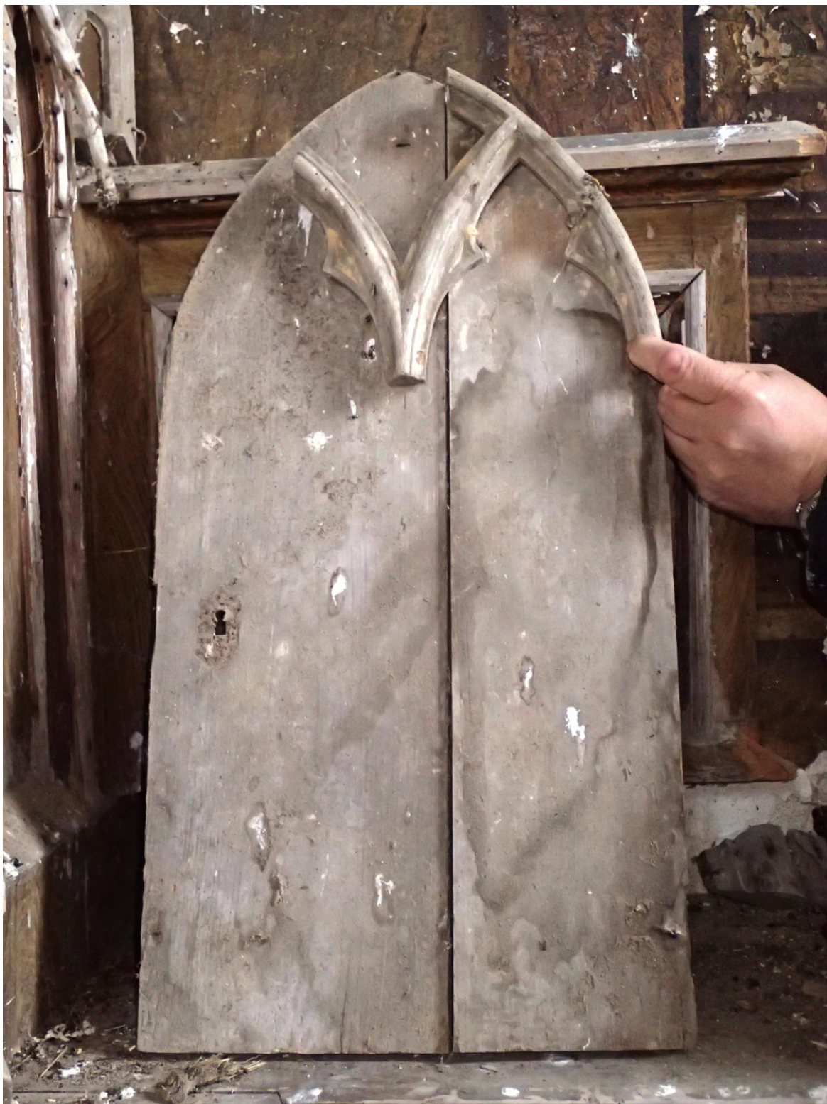
OBR . 16 Stav při průzkumu – detail dvířek svatostánku Zdobení dvířek profilovanými žebry ve tvaru lomeného oblouku se dochovalo pouze v torzu, nicméně podle dochovaných částí lze dvířka rekonstruovat. Chybí zámeček.
