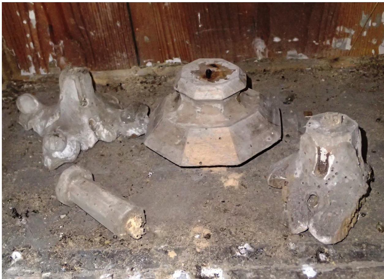
OBR . 19 Stav při průzkumu – detail výzdoby svatostánku - fiály Podle dochovaných zbytků fiál bude možné jejich celkový vzhled rekonstruovat.
