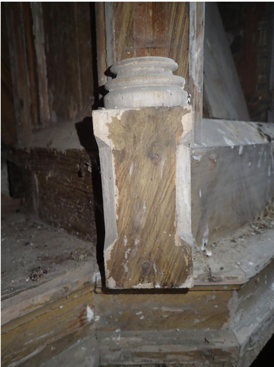
OBR . 14 Stav při průzkumu – detail sloupku svatostánku – sokl s patkou Dobře patrná je kresba fládru na plochách.
