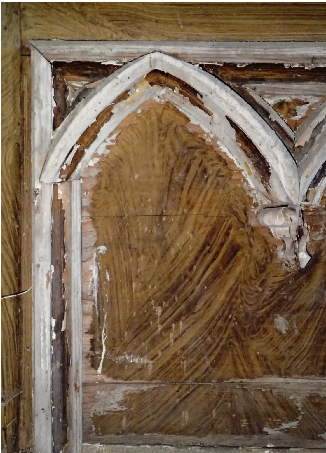
OBR . 21 Stav při průzkumu – detail – čelo predely Dobře patrné je poškození výzdoby i kresba fládrování.
