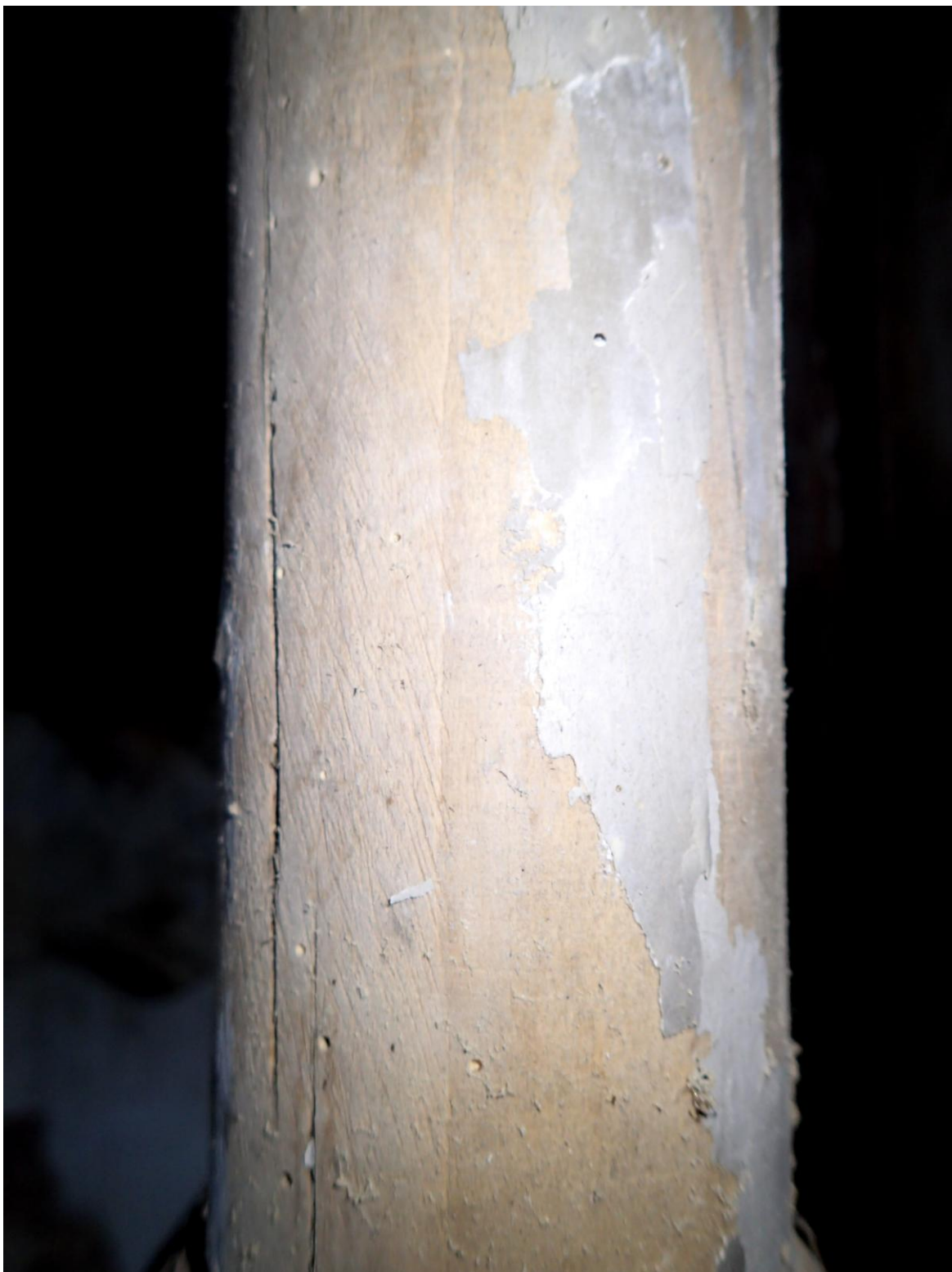
OBR . 29 Stav při průzkumu – detaily menzy Detail sloupku v rozích menzy. Na sloupcích je šedá barevná vrstva na křídovém podkladu.
